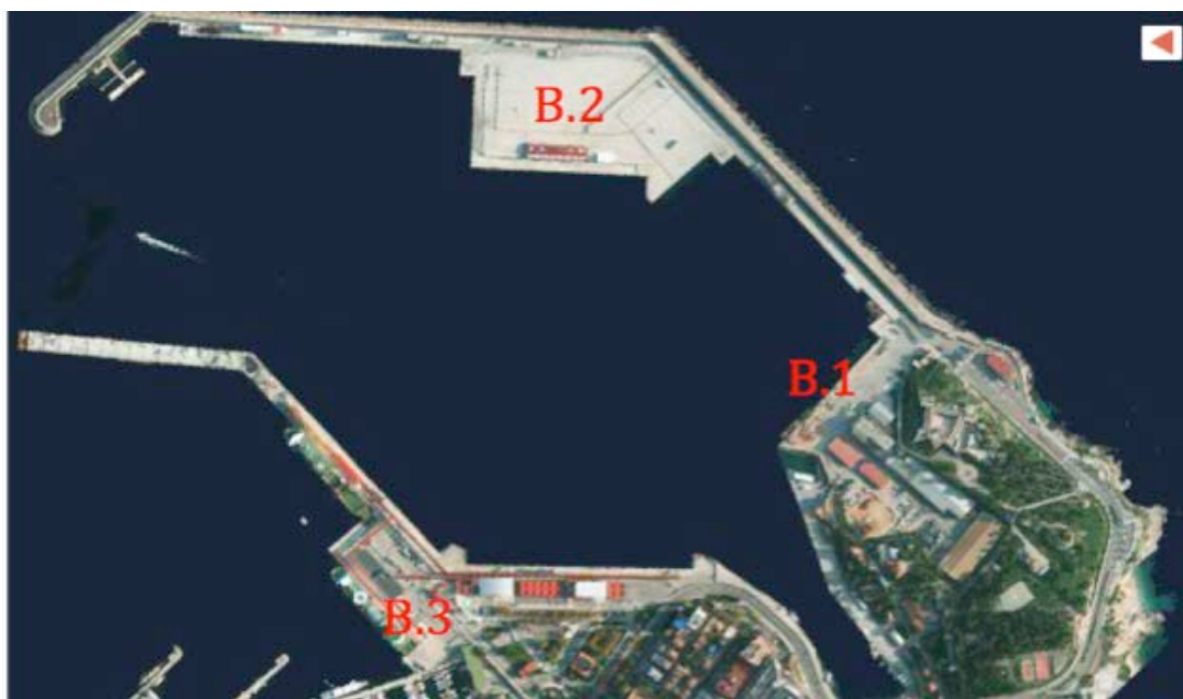
Puerto Palma de Mallorca. Zona: Dique del Oeste/Muelles de Poniente. B1: Muelle Ribera en San Carlos; B2: Alineación norte en plataforma adosada; B3: Muelle de Poniente.
