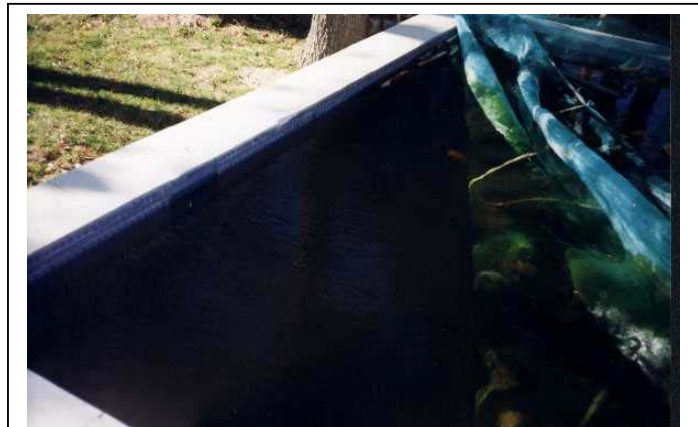
Fot. 7: Aspecto del tanque de agua. Agosto 2000
