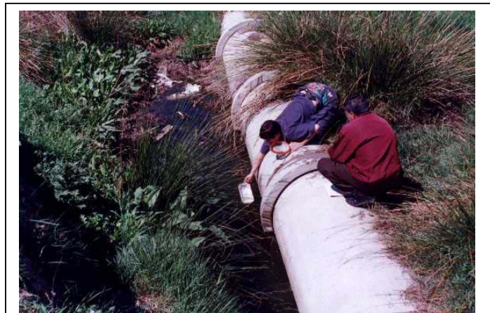
Fot. 17: Aspecto del cauce del Arroyo Ardoz. Torrejón de Ardoz. Mayo 2001
